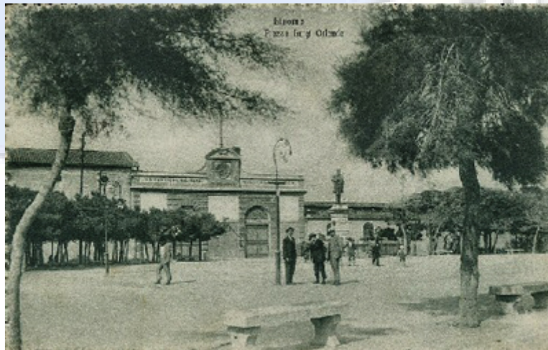
Il Cantiere Luigi Orlando
